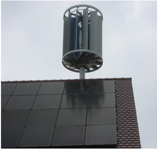
Abb. 1. Installation einer 1 kW Turbina-VAWT auf einem Hausdach.
